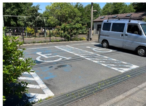
梶野公園の障がい者用駐車場（2台）
